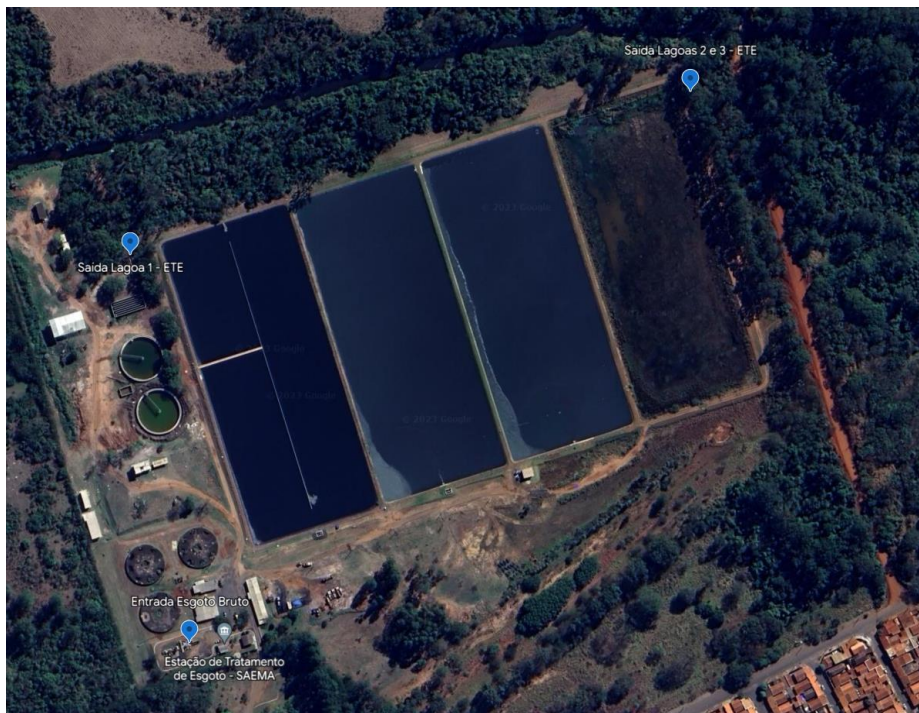
Localização dos pontos 01, 02 e 03 do Lote 01 – Fonte: Imagem Google Earth
