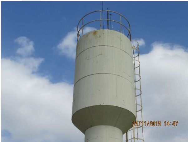
Figura 153 – Vista externa do reservatório.
