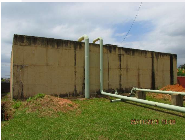
Figura 102 – Vista geral do reservatório
