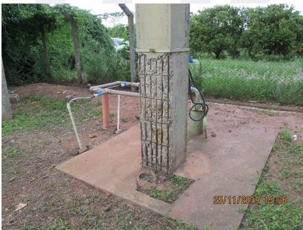
Figura 145 – Pilar degradado
