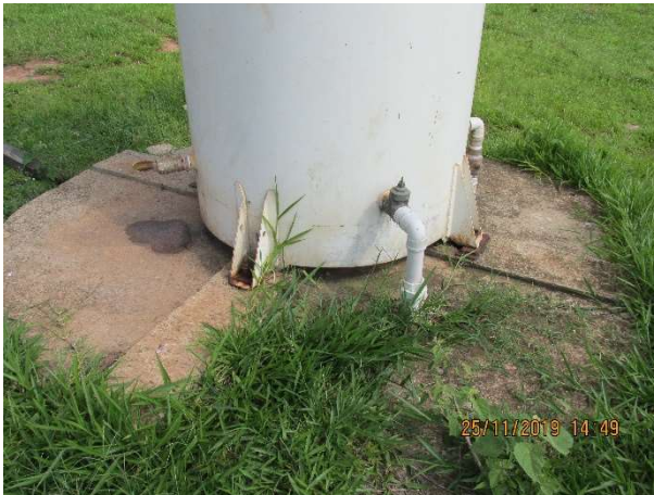
Figura 158 – Vista externa do reservatório.
