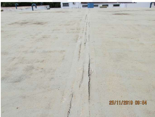
Figura 4 – Laje de cobertura
