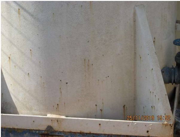
Figura 170 – Vista externa do reservatório.
