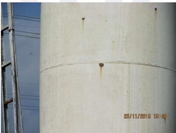
Figura 160 – Vista externa do reservatório.
