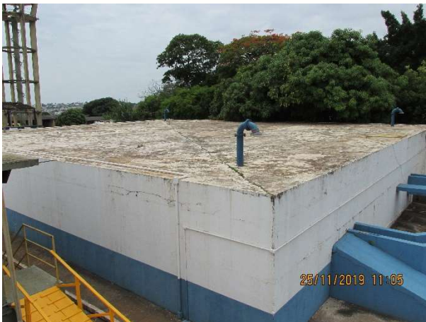
Figura 45 – Laje de cobertura
