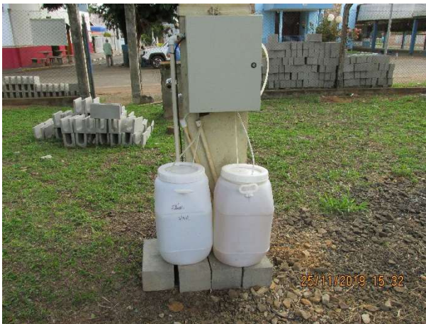
Figura 150 – Estrutura interna dos reservatórios.
