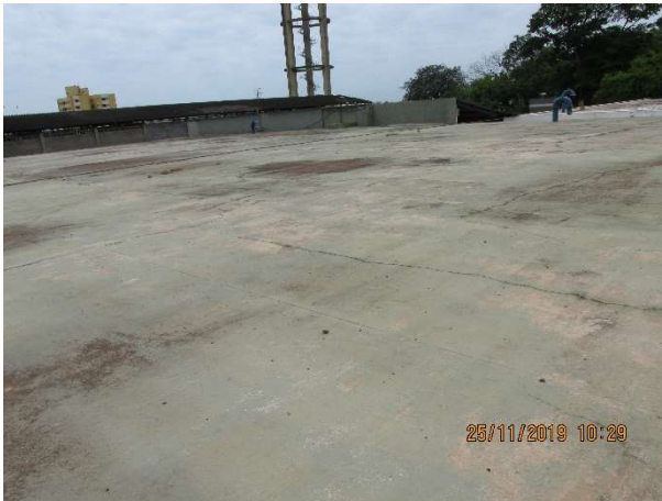
Figura 23 – Laje de cobertura
