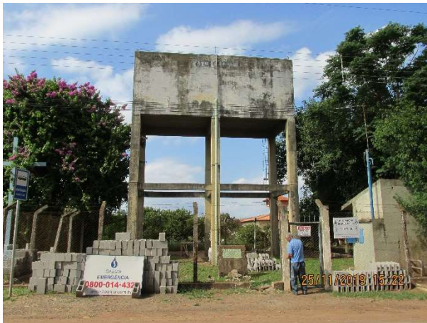
Figura 134 – Vista geral do reservatório
