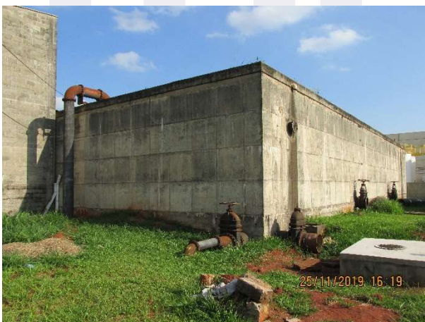
Figura 121 – Vista geral do reservatório.
