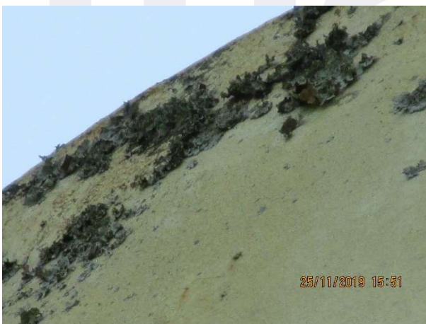
Figura 166 – Vista externa do reservatório.
