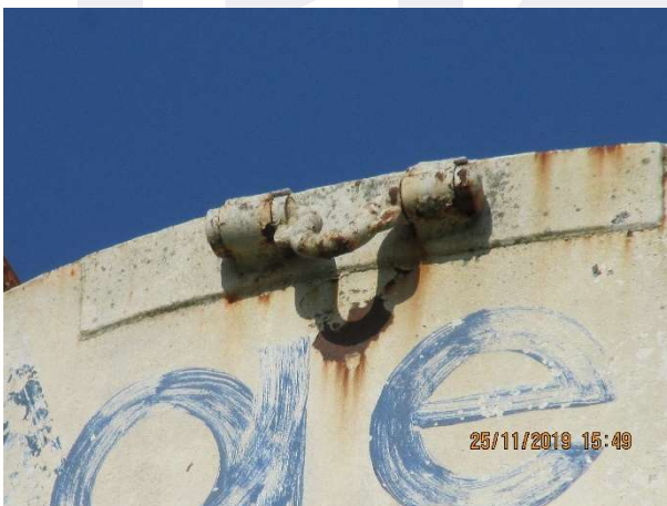
Figura 163 – Vista externa do reservatório.
