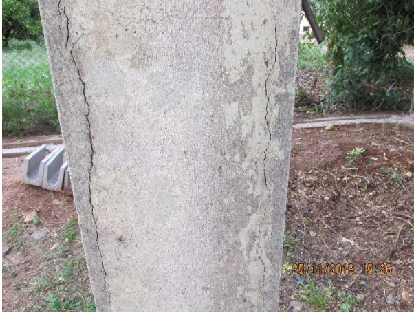
Figura 143 – Pilar degradado
