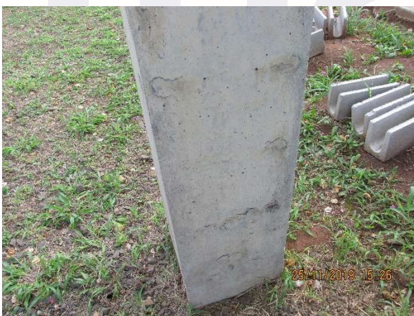
Figura 148 – Pilar degradado
