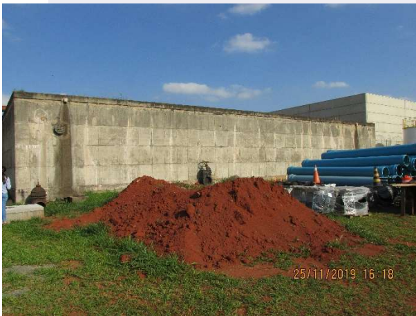
Figura 120 – Vista geral do reservatório
