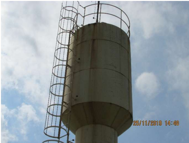
Figura 155 – Vista externa do reservatório.
