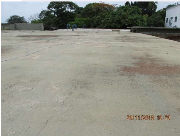
Figura 21 – Laje de cobertura
