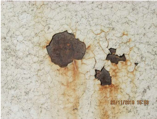
Figura 171 – Vista externa do reservatório.
