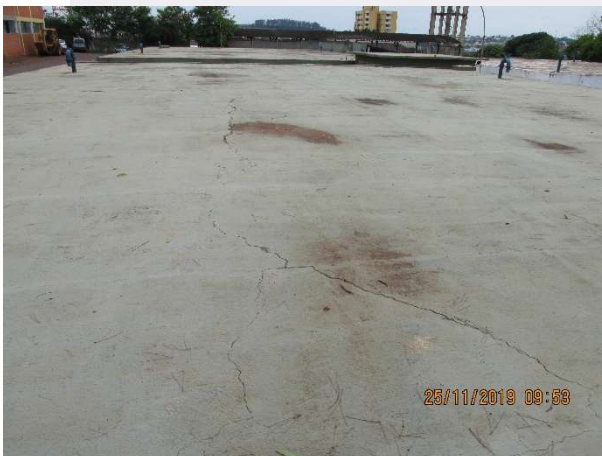
Figura 3 – Laje de cobertura
