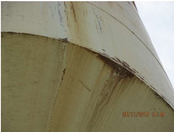
Figura 156 – Vista externa do reservatório.
