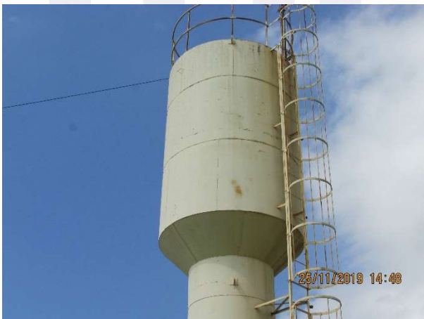
Figura 154 – Vista externa do reservatório.
