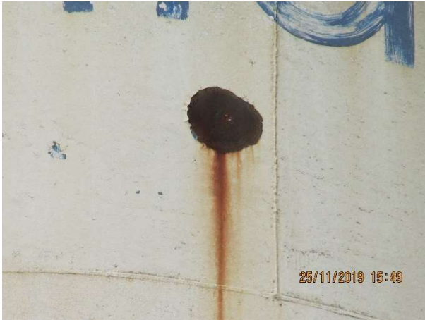
Figura 162 – Vista externa do reservatório.
