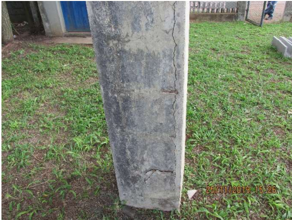
Figura 144 – Pilar degradado
