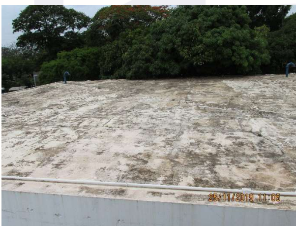
Figura 46 – Laje de cobertura
