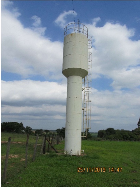
Figura 152 – Estrutura externa do reservatório.
