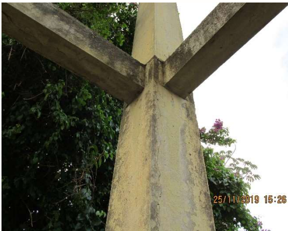
Figura 147 – Pilar degradado
