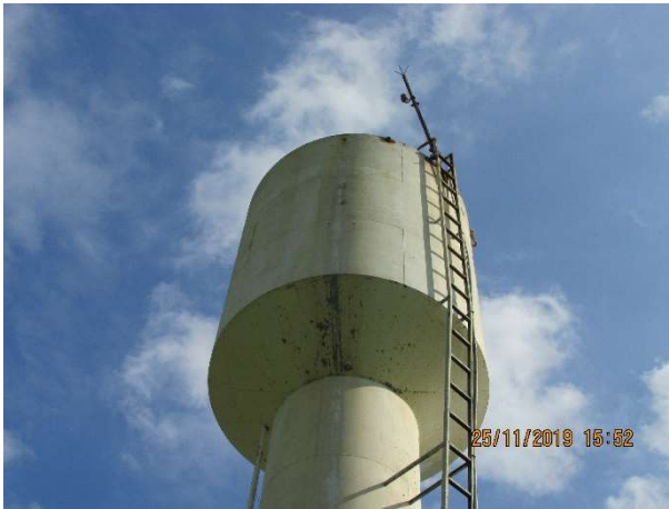
Figura 167 – Vista externa do reservatório.
