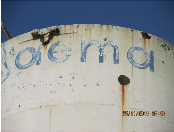
Figura 161 – Vista externa do reservatório.
