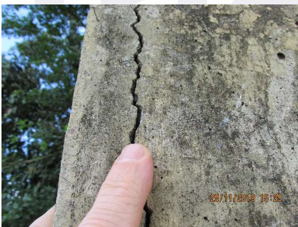
Figura 142 – Pilar degradado
