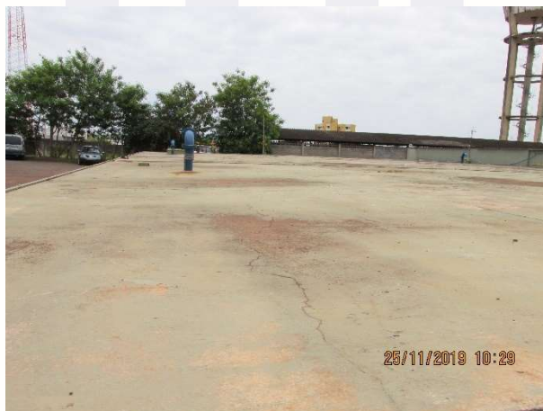
Figura 22 – Laje de cobertura
