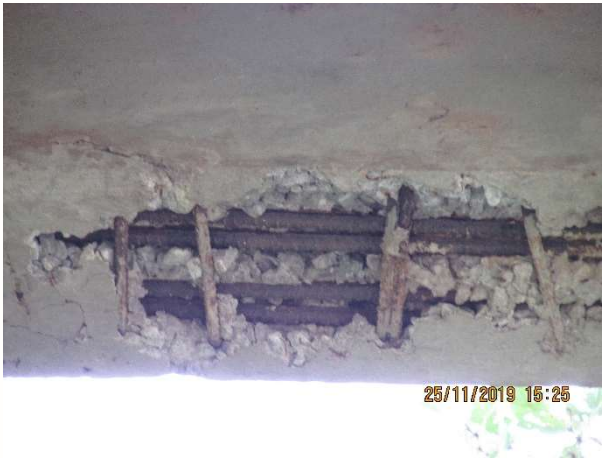
Figura 140 – Viga com nicho de concretagem
