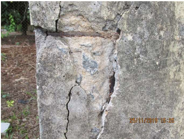
Figura 141 – Pilar degradado
