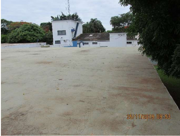
Figura 2 – Laje de cobertura
