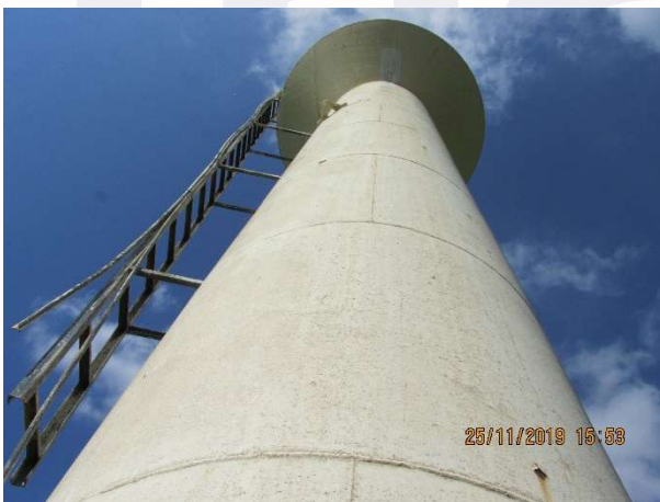
Figura 172 - Vista externa do reservatório.
