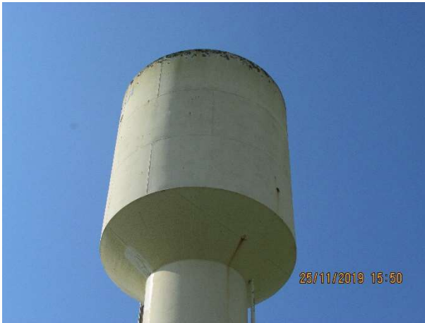
Figura 164 – Vista externa do reservatório.
