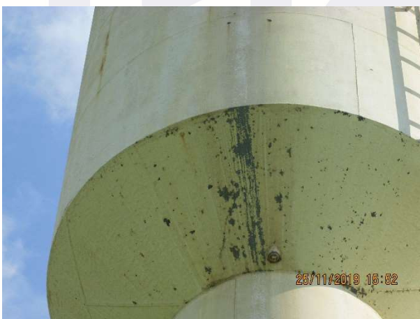
Figura 169 – Vista externa do reservatório.
