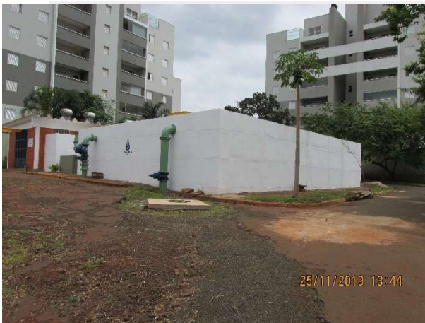
Figura 87 – Vista geral do reservatório
