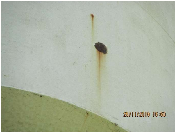
Figura 165 – Vista externa do reservatório.
