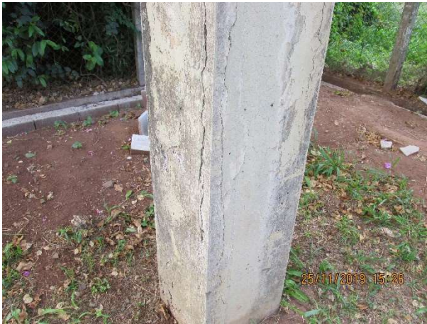
Figura 146 – Pilar degradado
