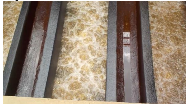
c) Distribuição de ar ao longo do Filtro 5 (100 s após início da lavagem com ar)
