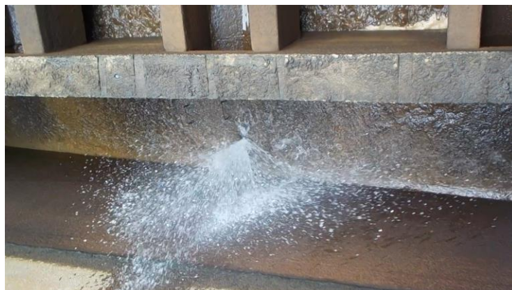
Figura 4.5 - Problema de vedação da tampa de inspeção do canal do Filtro 2 Fonte: Hidrosan (2018)
