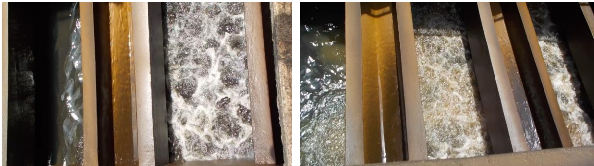
a) Início da lavagem com ar
