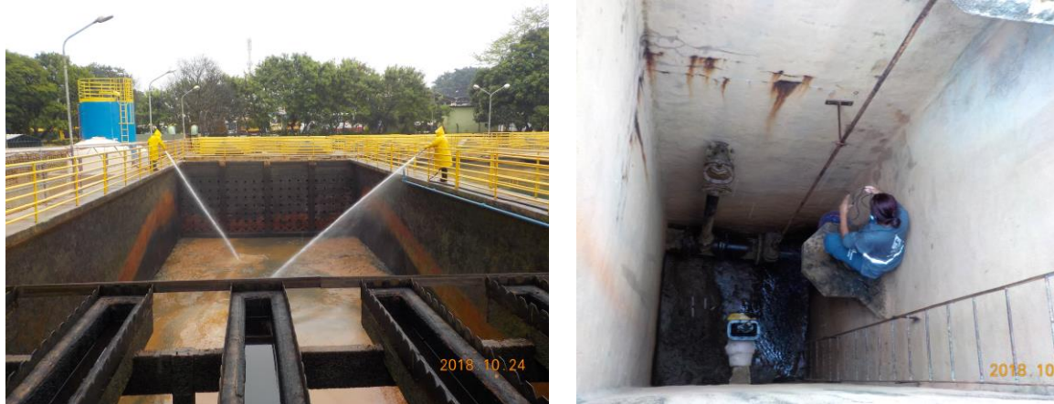
Figura 4.15 - Limpeza do decantador 1 e coleta de amostras durante a limpeza no dia 24 de outubro de 2018 Fonte: Hidrosan (2018)
