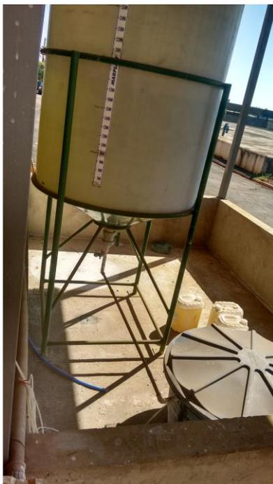
Figura 2.31 – Foto do tanque de armazenamento da solução de ácido fluossilícico
