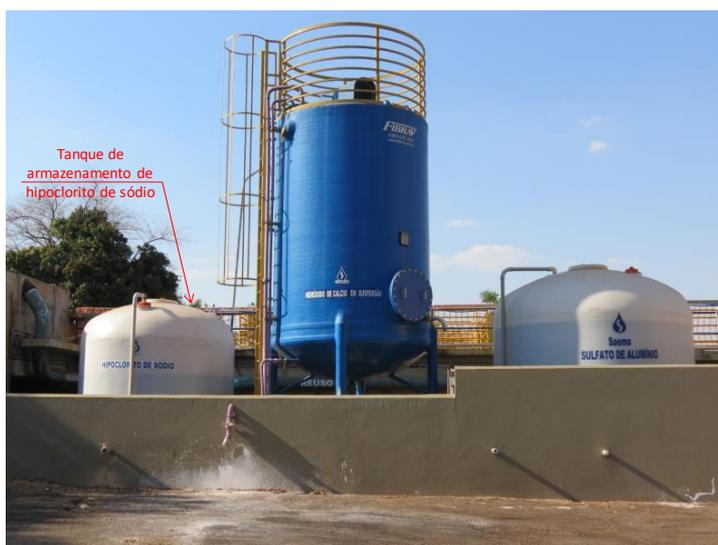
Figura 2.20 – Foto dos tanques de armazenamento de hipoclorito de sódio
