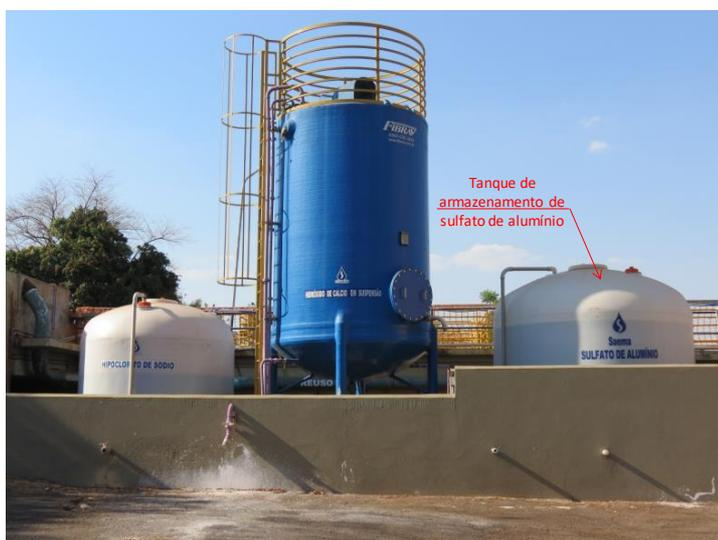
Figura 2.24 – Foto do tanque de armazenamento de sulfato de alumínio
