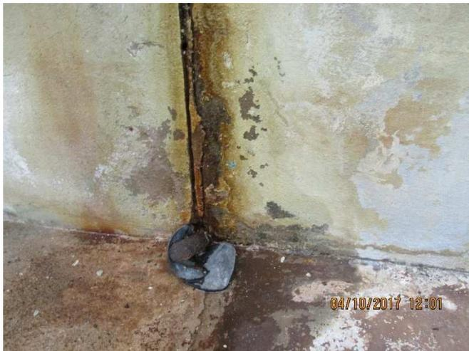
Objeto estranho colocado para sanar possível vazamento de água pela junta de movimentação.
