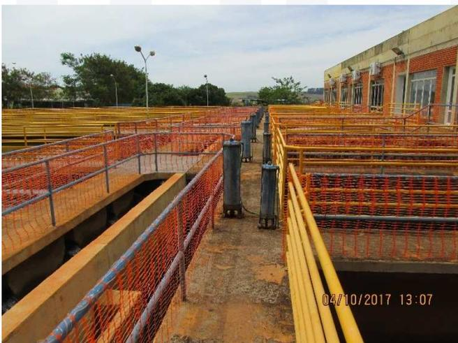
Vista geral das passarelas da ETA com sinais de falta de manutenção e conservação.
