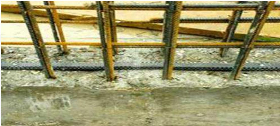
Figura 5 – Instalação de Fita Hidro Expansiva Water Stop nas juntas frias de concretagens (entre as armaduras)
