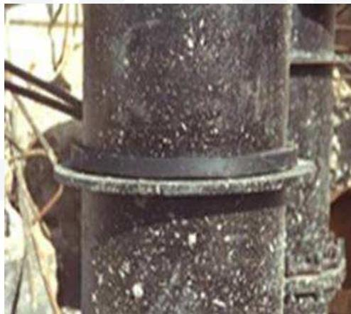
Figura 6 – Instalação de Fita Hidro Expansiva Water Stop ao redor de tubos passantes pelo concreto
