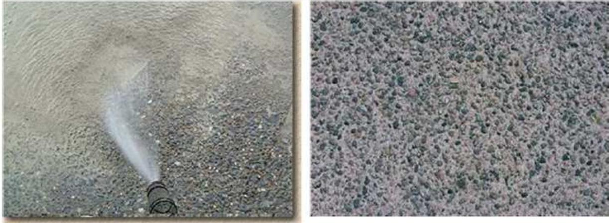
Figura 7 - Vista da condição ideal de acabamento do concreto após executado o corte verde
