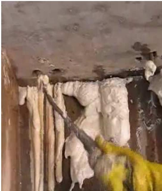
Figura 12 – Aplicação da injeção com espuma hidro ativada
