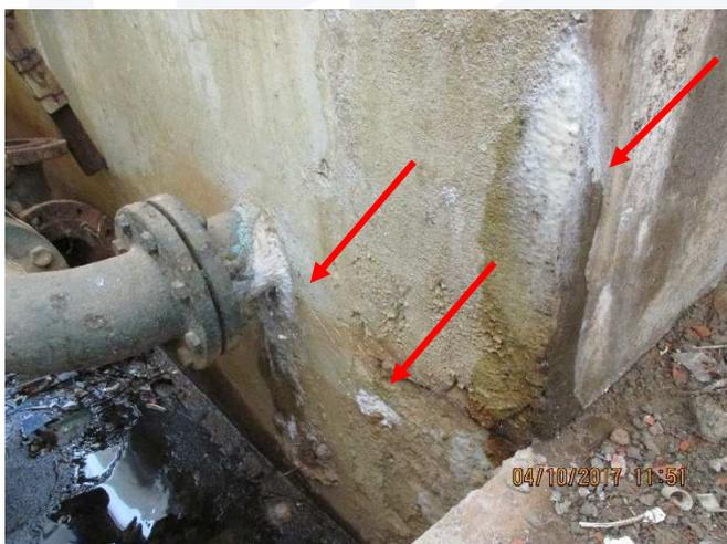
Pontos com lixiviação do concreto e com presença de umidade.
