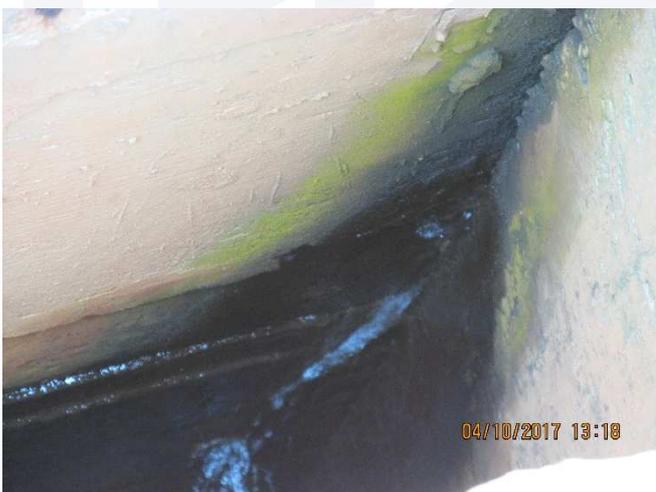
Infiltração de água pela junta de concretagem da figura 226.
