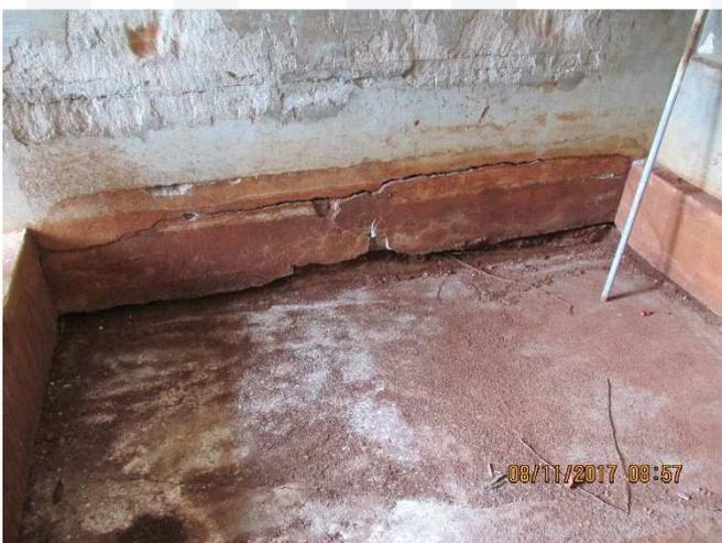
Figura 296 – Sala de depósito - trincas / umidades / afundamentos
