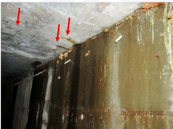
Figura 191 - Encontro entre laje de fundo decantador e canaleta dos filtros
