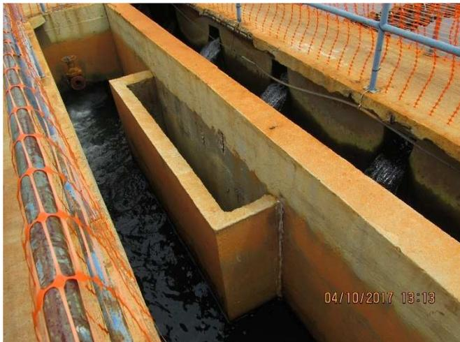
Figura 214 - Canal de distribuição dos filtros
