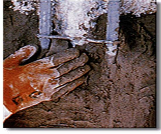
Figura 1 – Reparo Manual com Argamassa Polimérica    Figura 2 - Reparo Manual com argamassa polimérica
