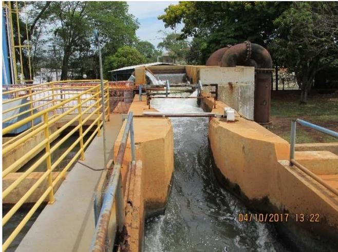
Figura 69 - Canaleta de entrada d'água na ETA
