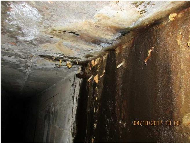
Registra-se que no encontro de planos entre a laje a e parede, foram realizadas injeções onde os bicos de injeção não foram removidos, assim como não foi dado o acabamento aos serviços. Nota-se que o vazamento continua.
