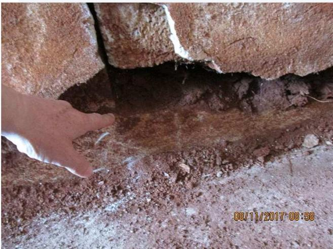
Figura 298 - Sala de depósito - trincas / umidades / afundamentos
