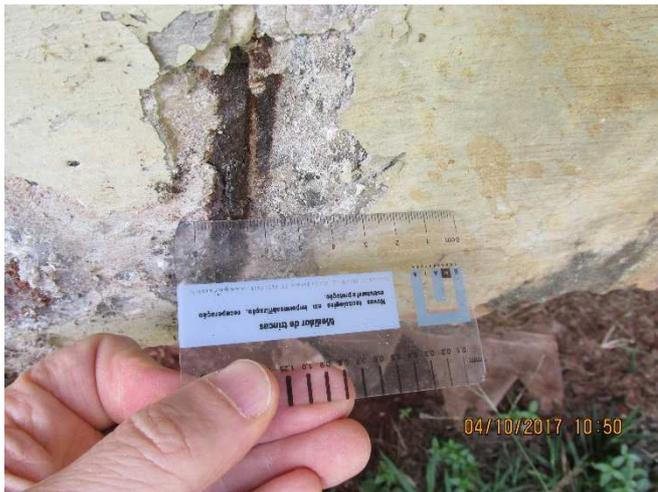
Deslocamento do concreto causado pela expansão do aço, gerado pelo processo de oxidação do mesmo.
