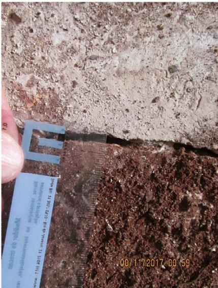
Trinca registrada na figura 299 com 5mm de espessura.
