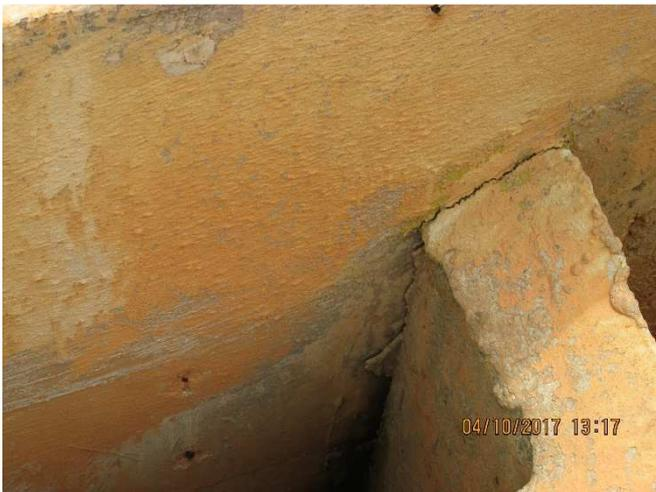
Fissura na junta de concretagem no encontro da parede da "caixa" com a parede da canaleta.
