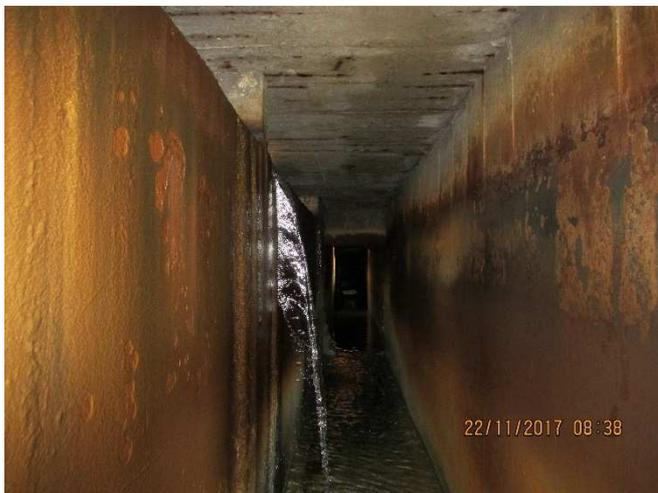
Foto interna da canaleta onde se vê corrosão das armaduras do teto, e impregnações nas paredes.
