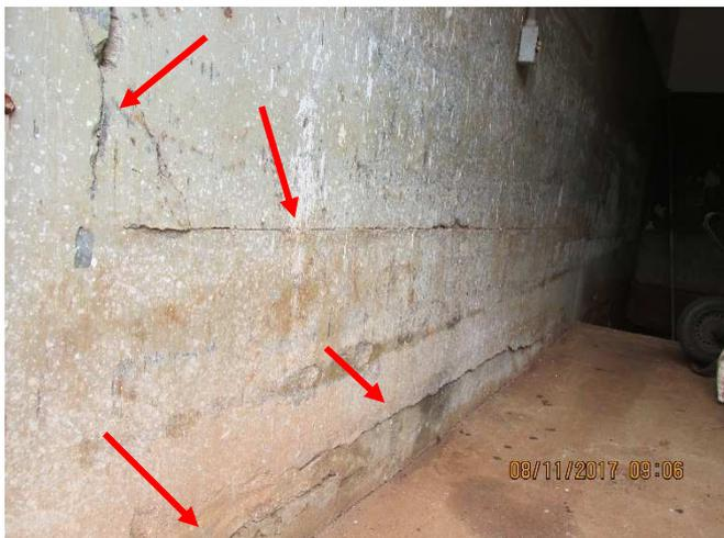
Figura 306 – Sala de depósito - trincas / umidades / afundamentos
