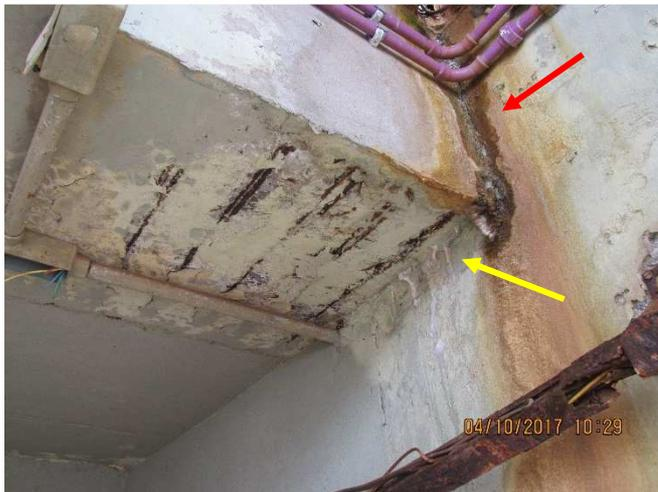
Deslocamento do concreto devido ao baixo cobrimento da armadura e a expansão da mesma causadas pelo processo de oxidação.
