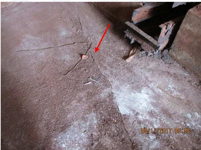
Figura 299 – Sala de depósito - trincas / umidades / afundamentos
