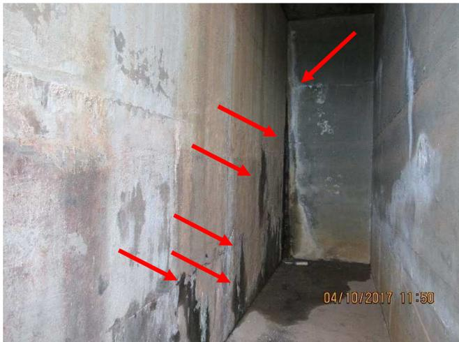
Figura 127 - Parede Externa entre filtros 04 e 05
