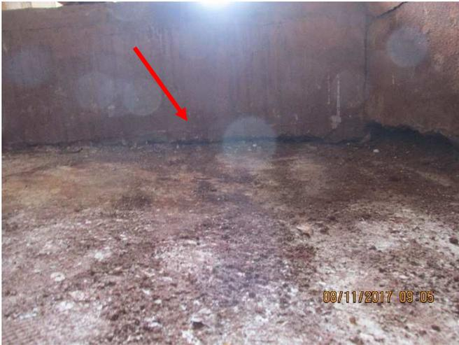
Figura 303 – Sala de depósito - trincas / umidades / afundamentos
