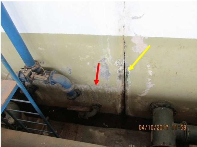
Figura 139 - Junta entre os filtros 07 e 08
