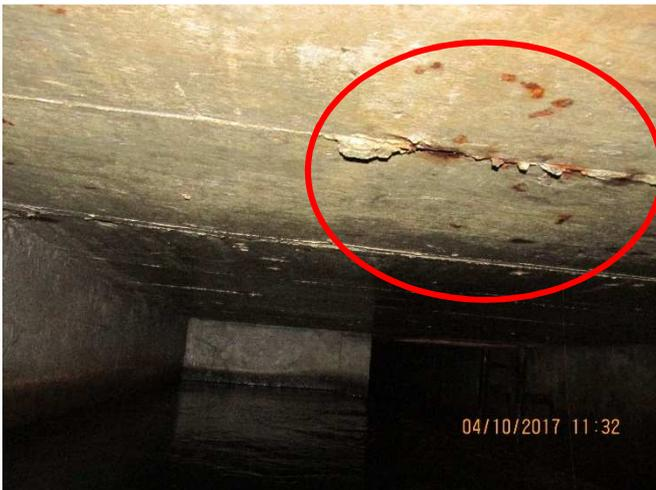
Diversos pontos de corrosão na laje de cobertura da canaleta.
