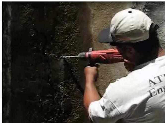
Figura 8 - PERFURAÇÃO DO SUBSTRATO PARA COLOCAÇÃO DOS BICOS DE INJEÇÃO INCLINADOS À 45º
