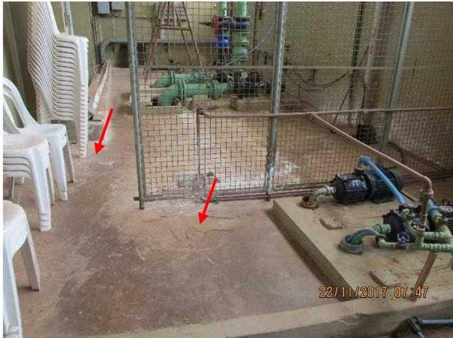
Laje de cobertura da canaleta de distribuição de água apresenta algumas fissuras (seta vermelha) indicando recalque da mesma devido afundamentos no solo.
