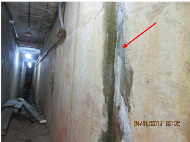
Fissura com presença de limos que provocam biodegradação do concreto também apresenta umidade e lixiviação.
