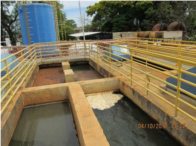
Vista geral dos flocladores 01 e 02 que mostra degradação generalizada do concreto que está sem revestimento de proteção e impermeabilização.
