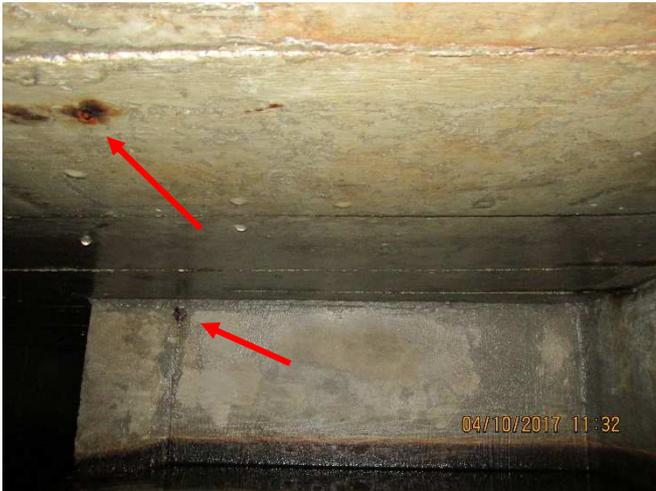
Pontos de corrosão na laje de cobertura no interior da canaleta.
