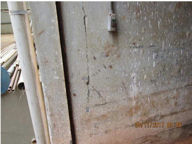
Figura 304 – Sala de depósito - trincas / umidades / afundamentos
