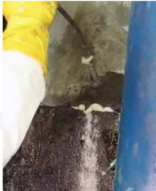
Figura 13 - Aplicação da injeção com espuma hidro ativada
