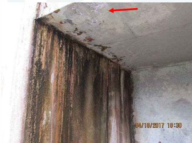
Registra-se que no encontro de planos da parede com a laje, onde foram realizadas injeções, porém os bicos de injeção não foram removidos, assim como não foi dado o acabamento aos serviços. Nota-se que ainda existe a presença de umidade e vazamentos.
