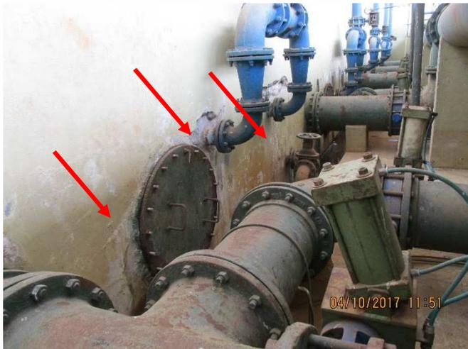
Diversas fissuras com eflorescência devido à lixiviação do concreto inclusive junto as tubulações.
