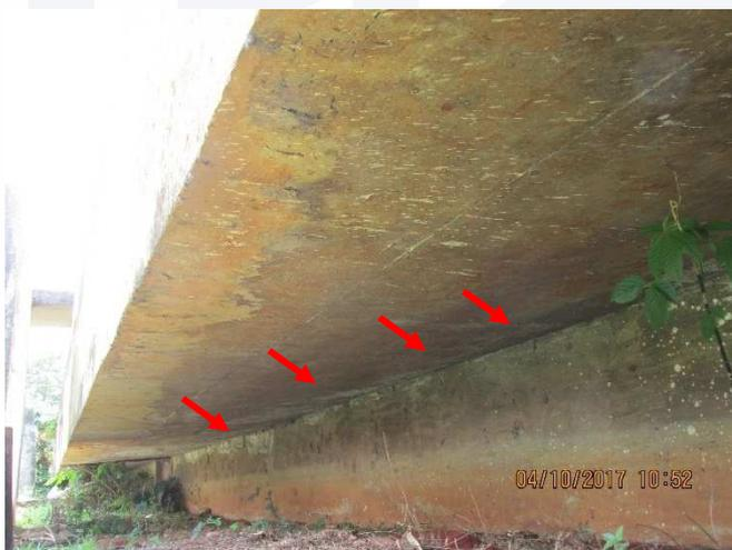
Verificasse pontos de vazamentos com lixiviação no encontro entre planos da parede com a laje.
