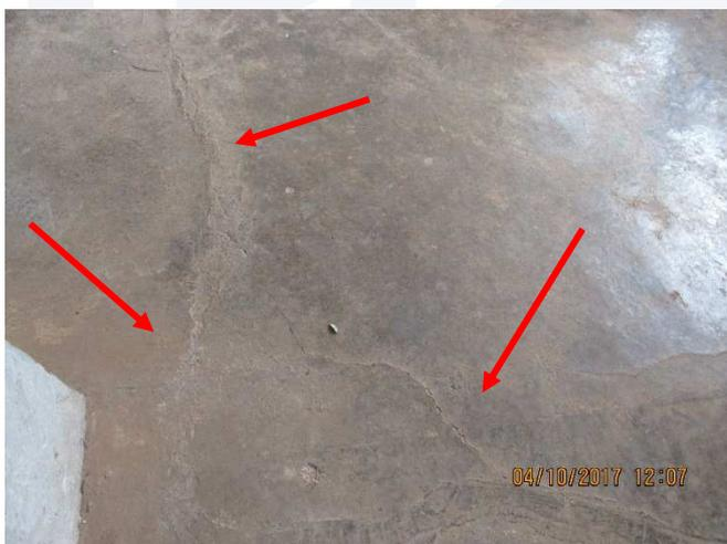
Diversas fissuras na laje de concreto devido a deformação estrutural do canal de água tratada, a baixo da laje.
