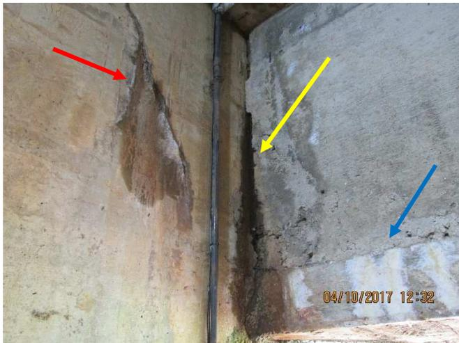
Fissura com presença de umidade e lixiviação (seta vermelha).
