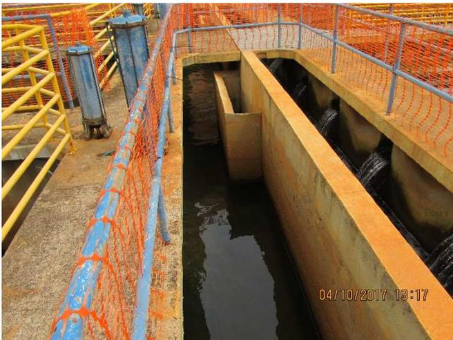
Vista geral da “caixa” de concreto na canaleta de distribuição dos filtros em frente aos filtros 03 e 04 que mostra degradação generalizada do concreto que está sem revestimento de proteção e impermeabilização.
