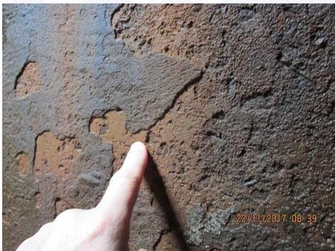
Degradação avançado do sistema de impermeabilização das paredes do canal
