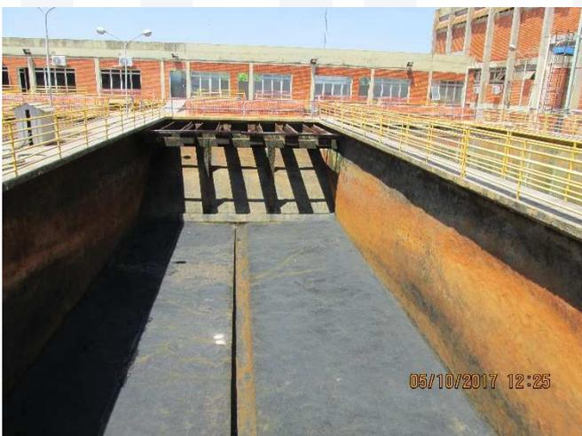
Vista geral do decantador 02 que mostra degradação generalizada do revestimento de argamassa de cimento e areia interna, executada sobre concreto; o revestimento está fissurado e sem proteção e impermeabilização.
