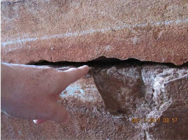
Figura 297 – Sala de depósito - trincas / umidades / afundamentos
