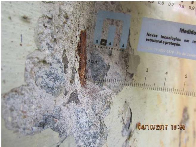
Verifica-se baixo cobrimento de concreto sobre o aço ( $c=13\text{mm}$ ).
