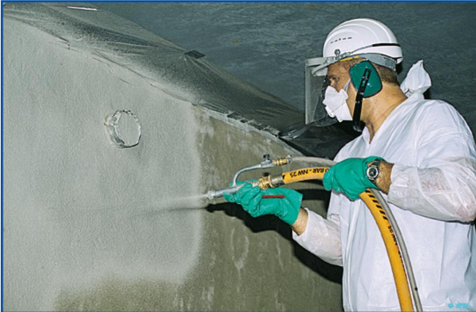
Figura 12 - Ilustração da aplicação do Sistema de Impermeabilização por projeção
