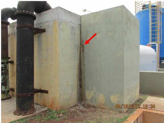
Figura 60 - Caneleta de entrada d'água na ETA
