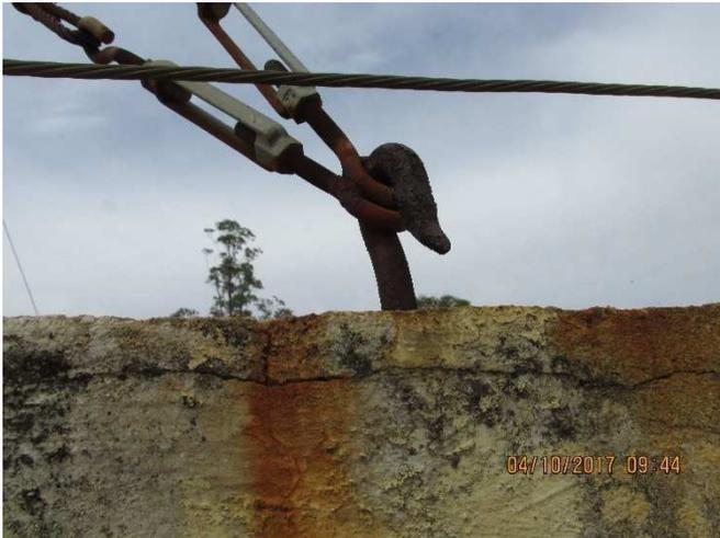
Figura 24 - Ponto de ancoragem da antena e para-raios
