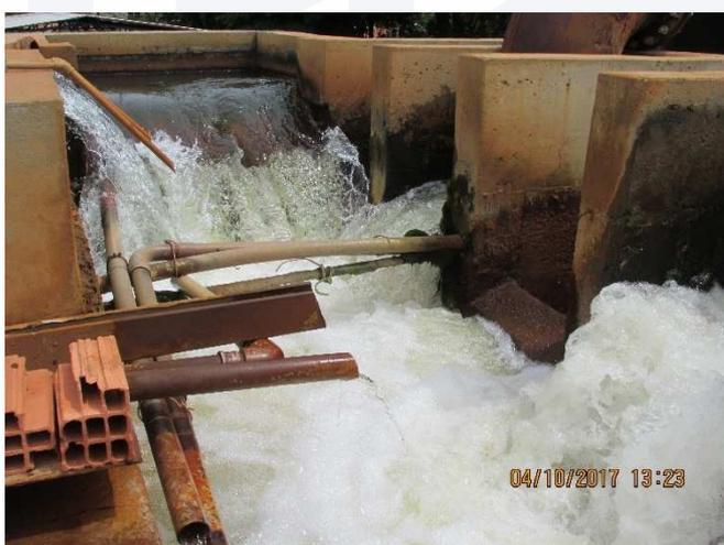
Figura 71 - Canaleta de entrada d'água na ETA
