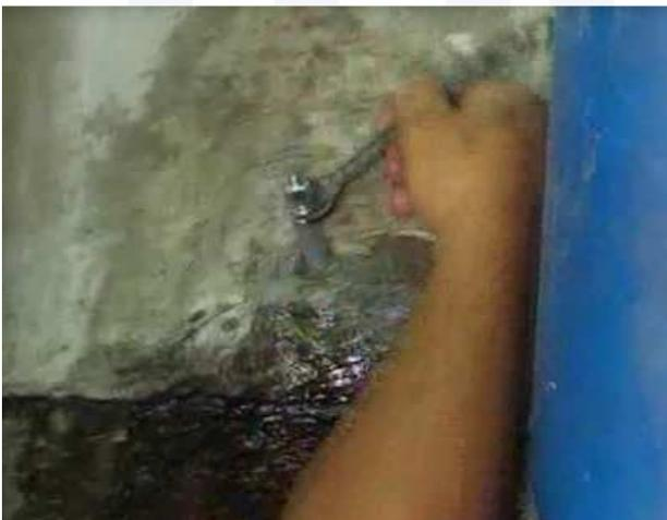
Figura 9 - DETALHE DA COLOCAÇÃO DOS BICOS DE INJEÇÃO
