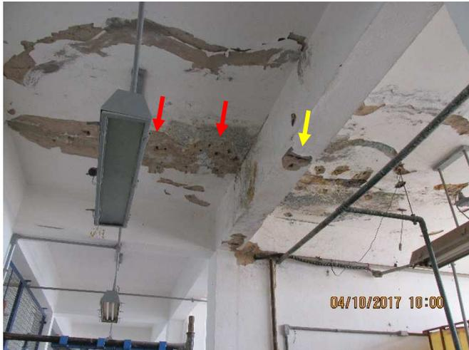
Figura 33 - Laje de fundo do reservatório
