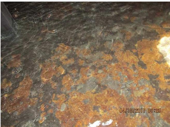
Sistema de impermeabilização degradado da laje de fundo.
