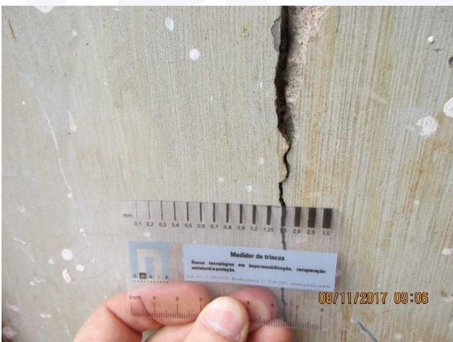
Figura 305 – Sala de depósito - trincas / umidades / afundamentos
