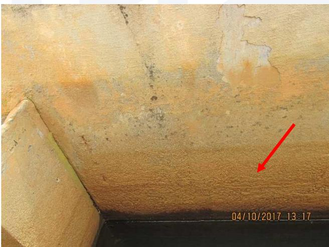
Sem impermeabilização e com o concreto erodido pela ação química e abrasiva da água.
