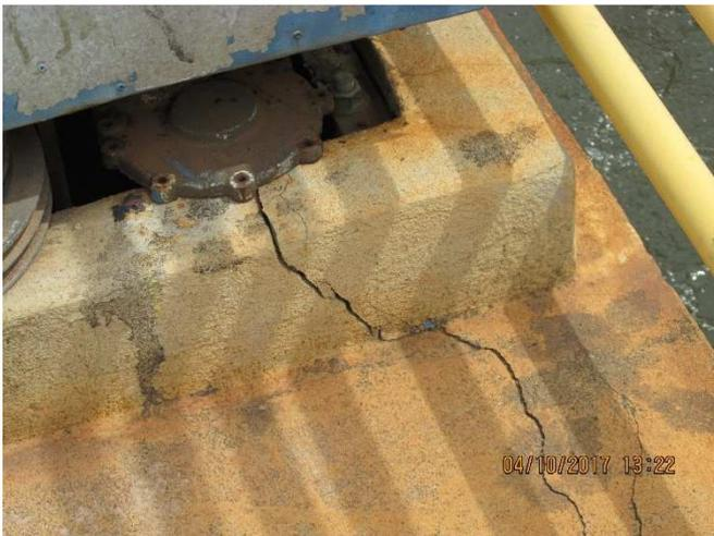
Trinca na passarela entre floclador e canaleta de entrada de água na ETA.
