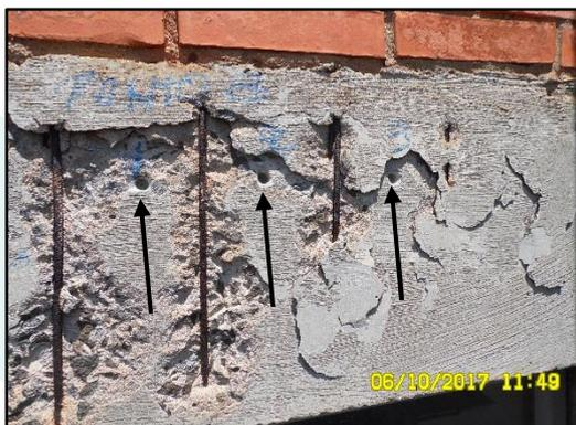
**Imagem 17:** Locais onde foram retiradas as amostras para ensaio de contaminação de sulfatos.
