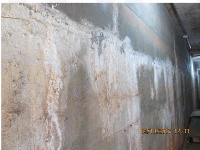
Lixiviação do concreto pela junta de concretagem.
