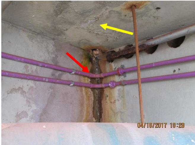
Fissura no encontro de paredes com presença de umidade (seta vermelha) e lixiviação da laje (seta amarela).
