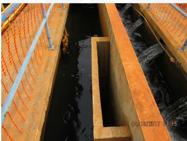
Figura 218 - Canal de distribuição dos filtros
