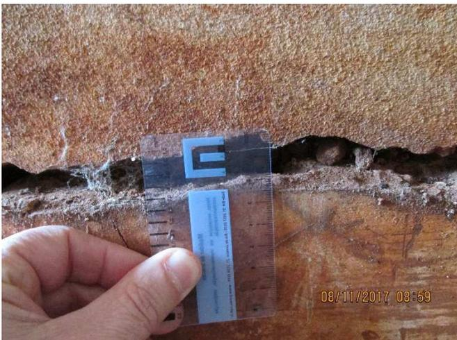
Trinca com 20 mm de espessura registrada na figura 302 (seta vermelha).
