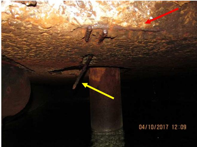
Figura 147 - Vista interna sob a laje do canal de água tratada
