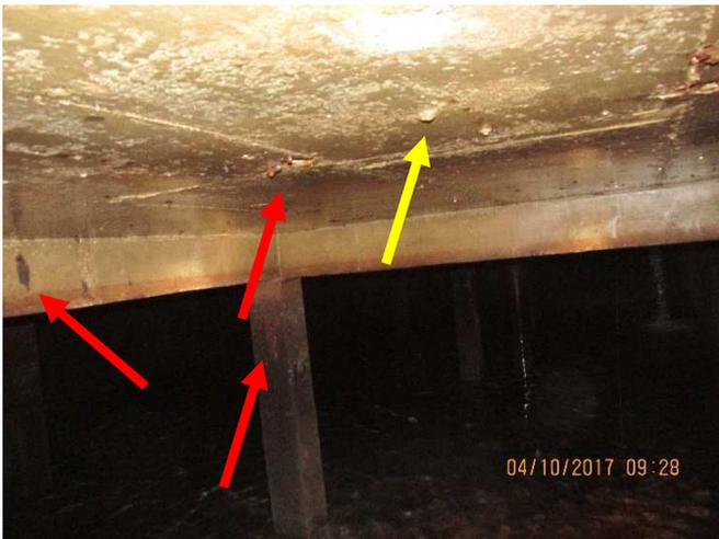
Pontos de corrosão na laje, viga e pilar do reservatório (setas vermelhas) e formação de estalactites (seta amarela).
