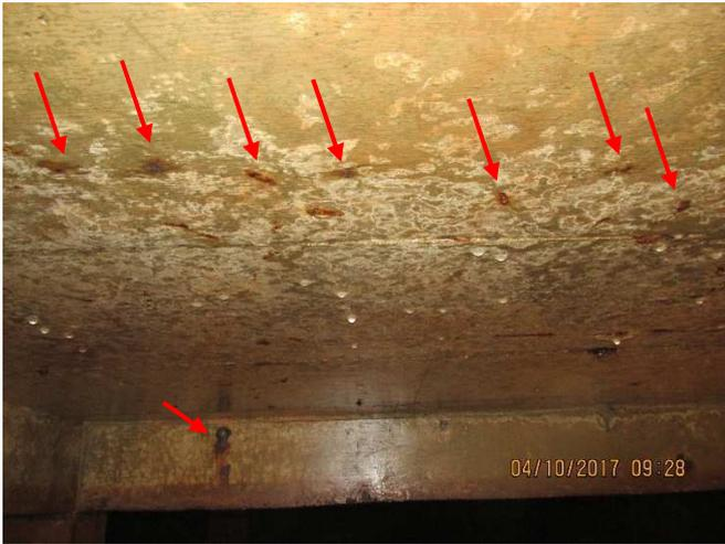
Pontos de corrosão na laje e viga do reservatório.
