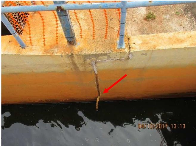
Figura 213 - Junta de dilatação no canal de distribuição dos filtros
