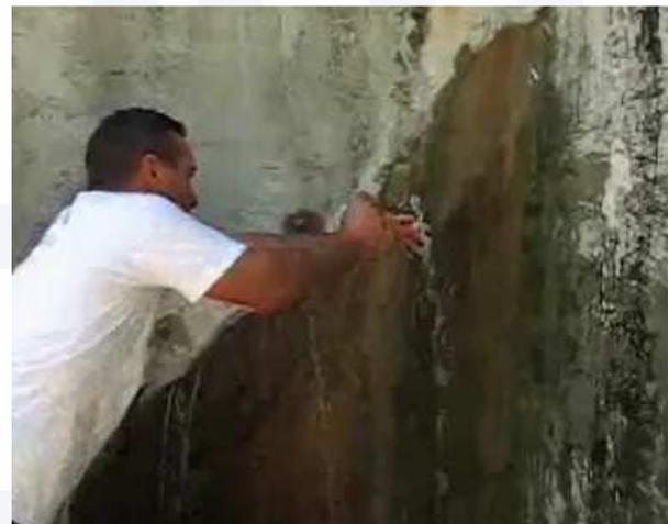
Figura 10 - COLOCAÇÃO DOS BICOS DE INJEÇÃO
